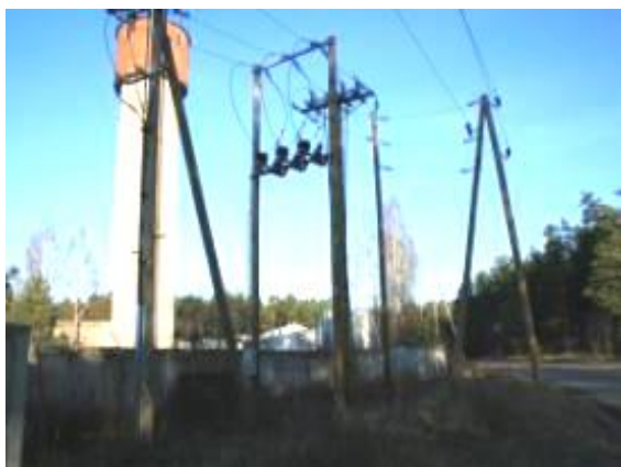
5.31. att. Sociālisma perioda būvniecības piemērs Pierīgā
