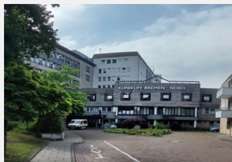
Nord GmbH, Klinikverbund, Bremen (Vācija)
